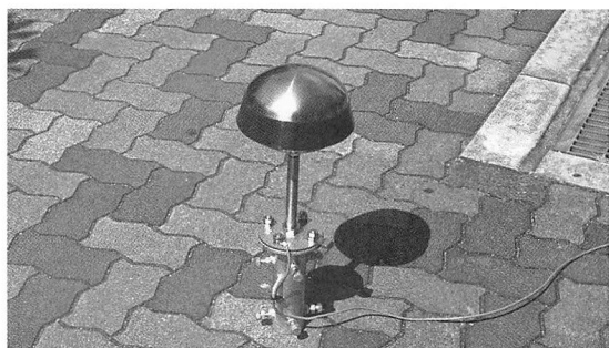
写真3 PDCE本体とジョイント金具とアースを仮接続
